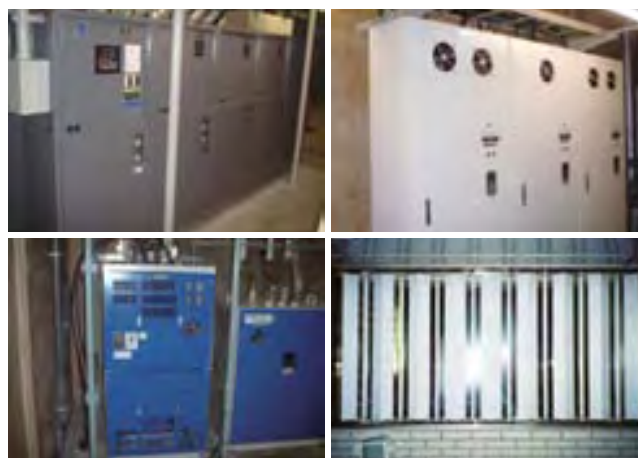
ホワイティうめだのESCO事業で使用した省エネ関連機器例 上段左:高効率冷凍機、右:インバータ盤 下段左:高効率トランス、右:高効率反射板
