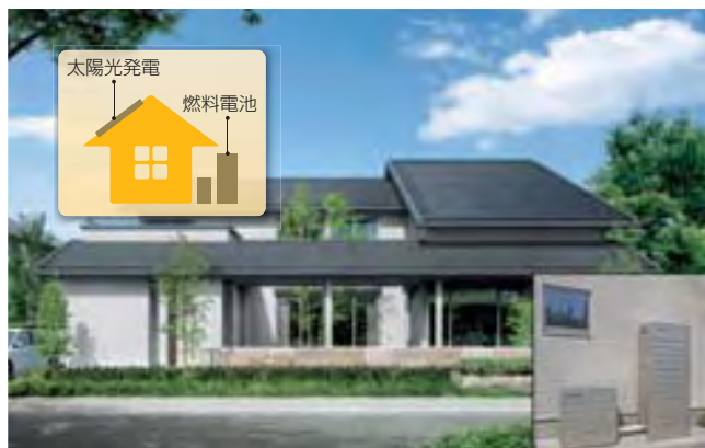
太陽光発電・燃料電池が搭載された積水ハウスの住宅
