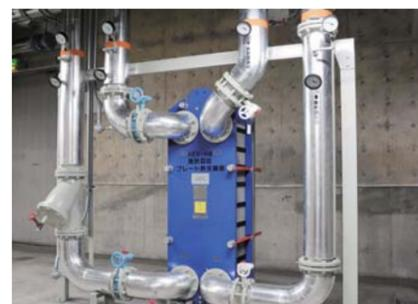
中央三井信託銀行調布センター廃熱回収プレート熱交換器
