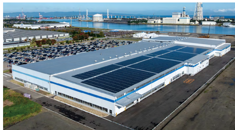
(支援PJ)新湊東工場
