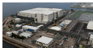
別子地区(愛媛県新居浜市)で 建設中の工場
