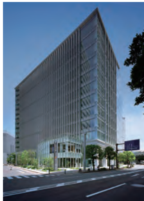
横浜プラザビル
