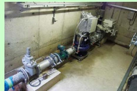
(管水路用マイクロ水力発電システム)
