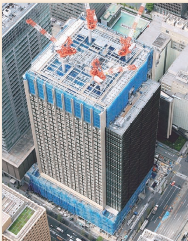
● 建築中の新本店ビル
